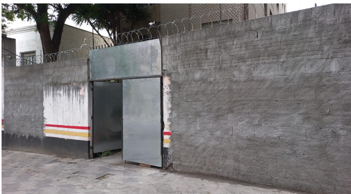
Obra de reforço perimetral
