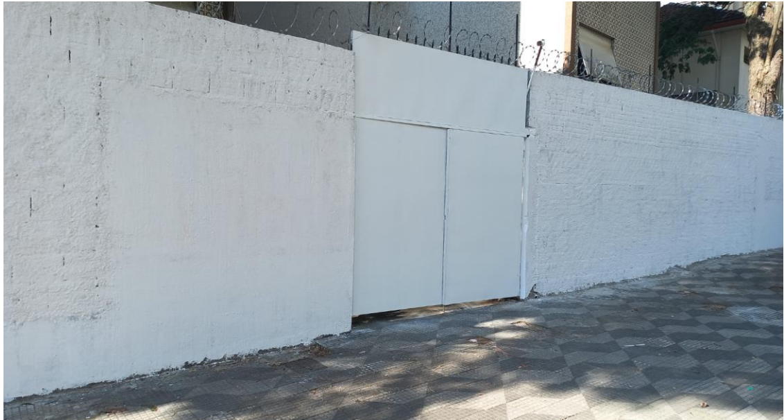
Muro frontal após pintura
