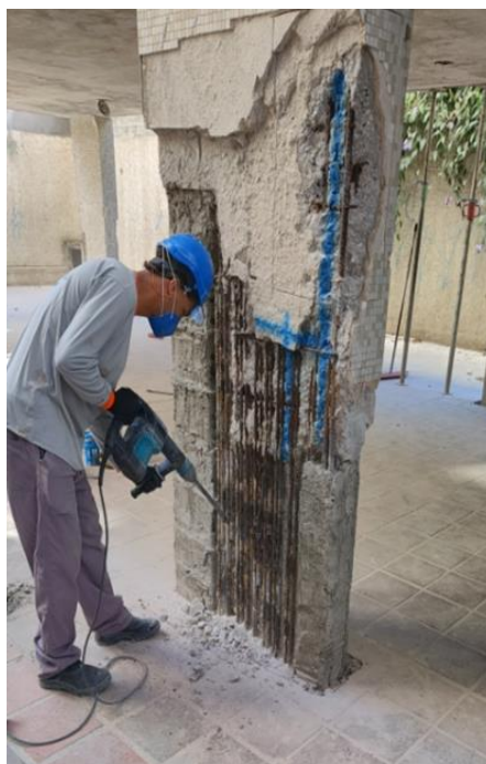
Retirada do concreto e tratamento da armadura
