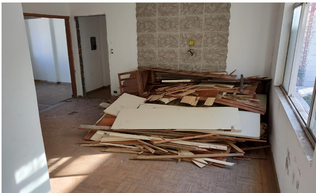
Demolição unidade com integração de ambientes.
