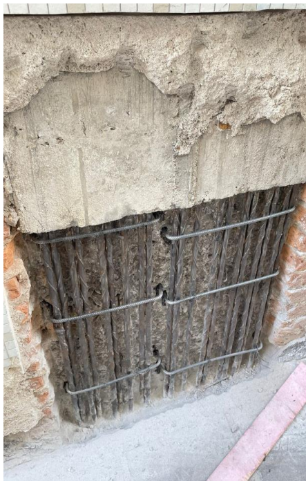
Armadura restaurada e novo argamassa polimérica aplicada
